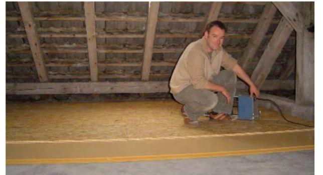
In Verbindung mit OSB-Platten kann Formline DFF auch in Trockenestrichsystemen eingesetzt werden. Im Bild eine orientierende Vorprüfung an der Hochschule Wismar.
